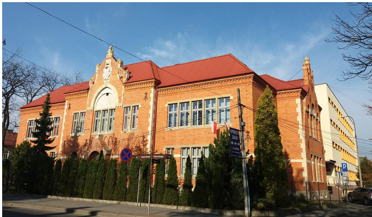
Na zdjęciu stary i nowy budynek szkoły.
